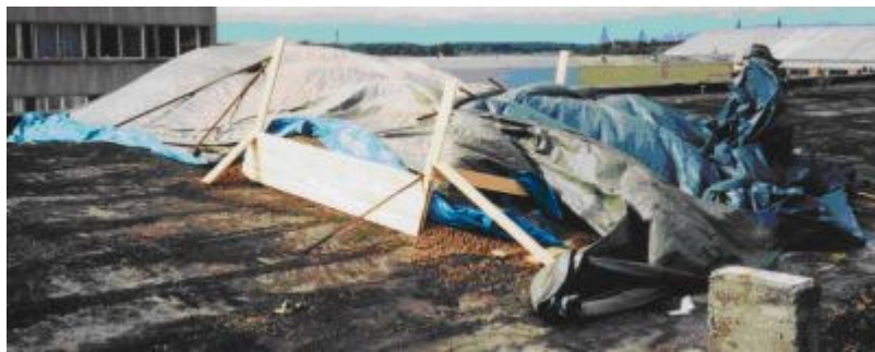
Foto 4 Kinnikaetud kergkruusakogus objektil.
