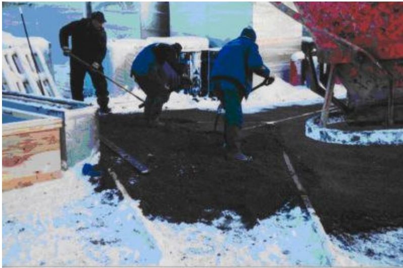
Foto 6 Kergkruusbetooni tõstmine ja laialilaotamine objektil
