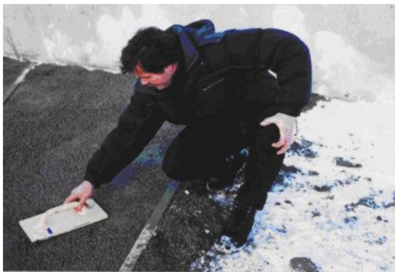
Foto 8 Kergkruusbetooni silumine hõõruti abil
