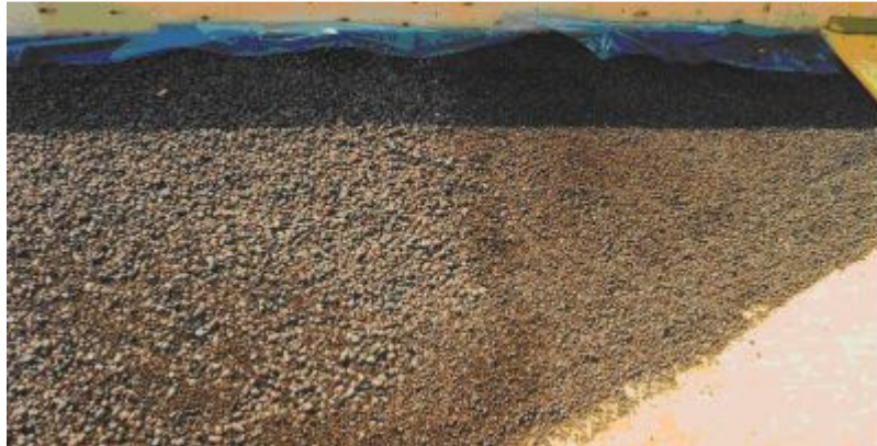
FOTO 18 Erinevate kergkruusafraktsioonide kasutamine neelukallete loomisel.
