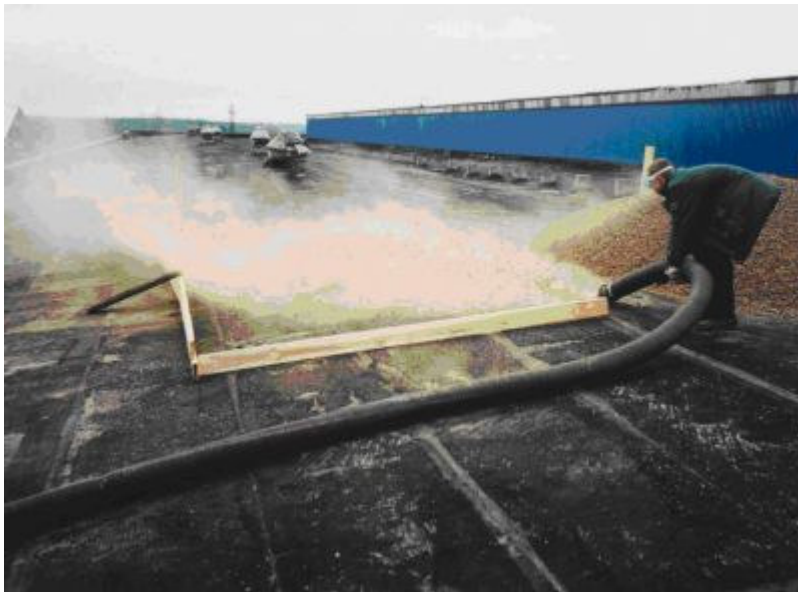
Foto 2 kergkruus saabub puhuriga varustatud autol kohale kuivana.
