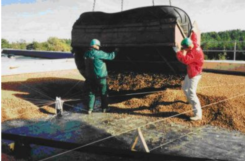
Foto 13 kergkruusa paigaldus tõstekasti abil
