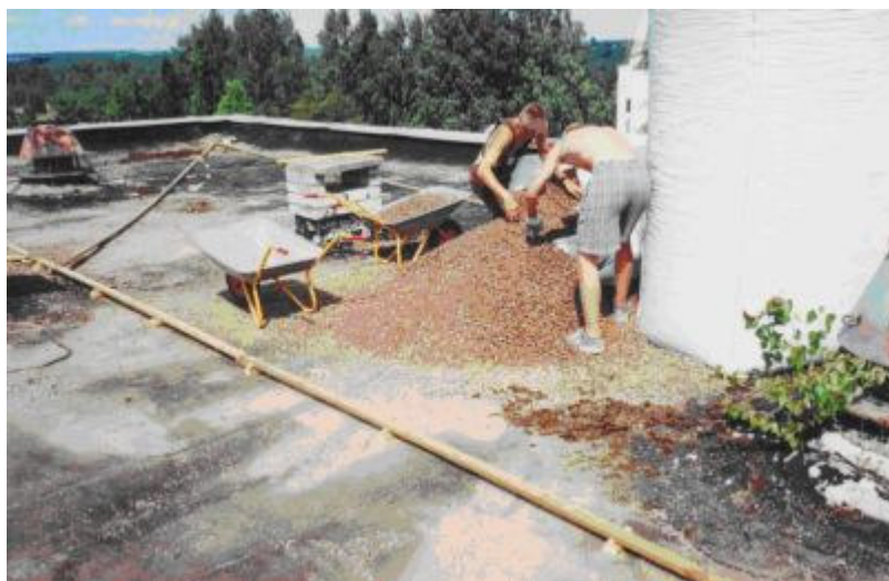
Foto 22 Kergkruusast lisakallete loomine renoveeritaval katusel
