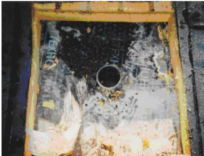
Foto 5 Tilkuva katusekaevu avamine
