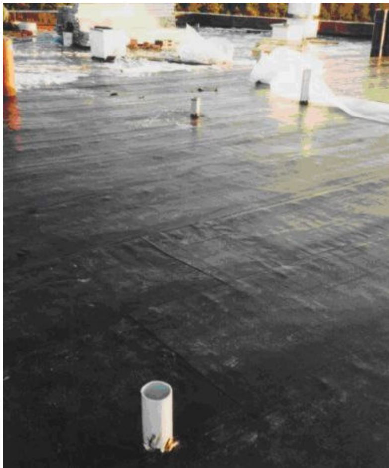
Foto 17 betoonist tasanduskihile on paigaldatud alumine hüdroisolatsioonikiht
