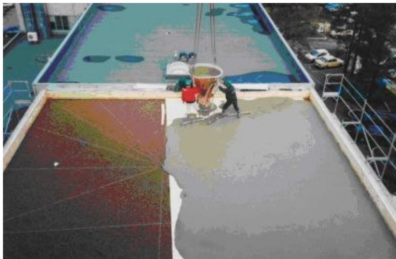
Foto 15 Tsementmördist tasanduskihi paigaldus
